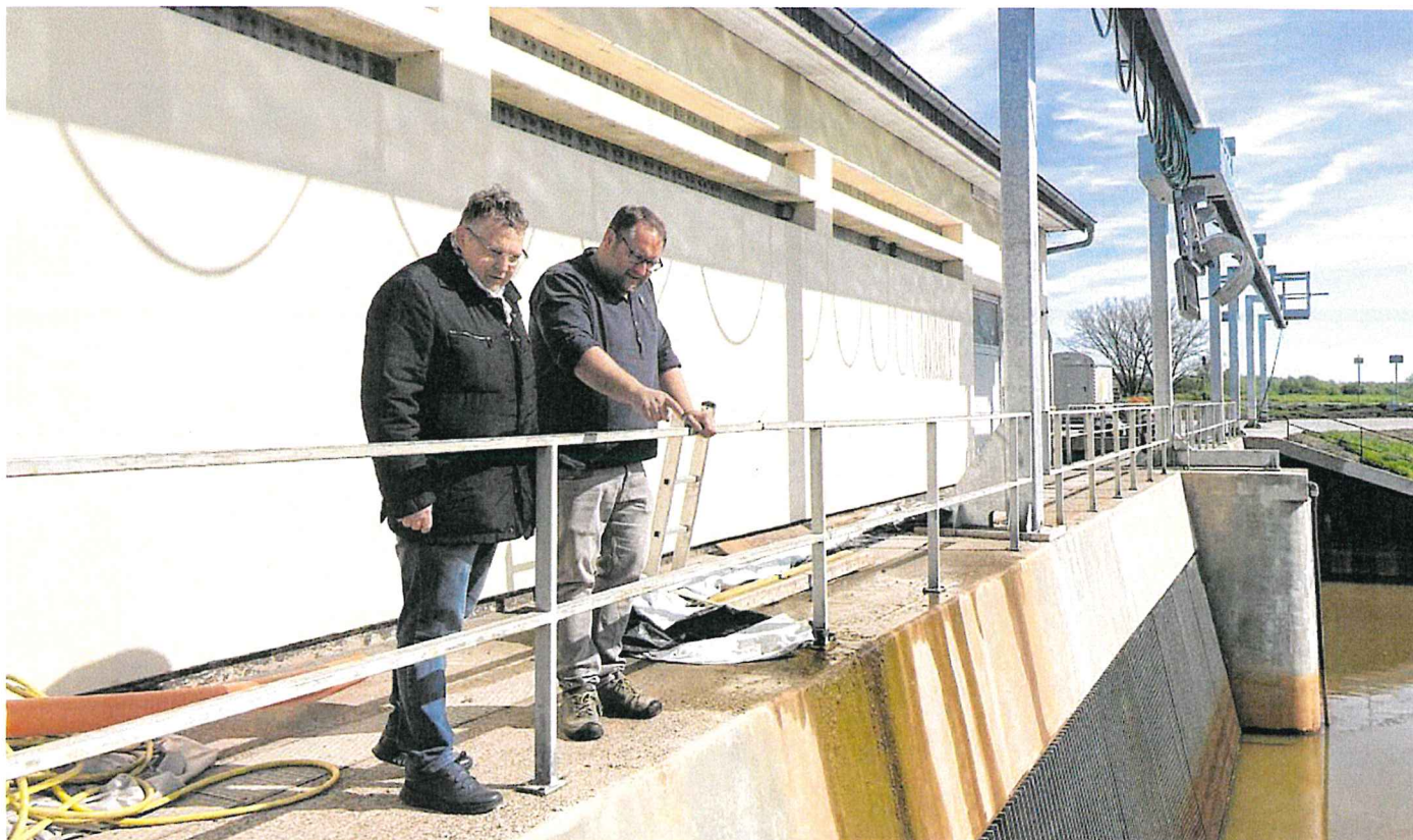
Peter Neumann (links) und Thomas Henrichmann vom Mittelweserverband inspizieren die Arbeiten am Schöpfwerk in Thedinghausen-Eißel.
