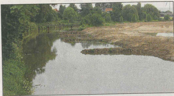
Bühnen ragen in die Eyter hinein. Sie sollen dazu beitragen, die Fließgeschwindigkeit zu erhöhen. • Foto: sp
