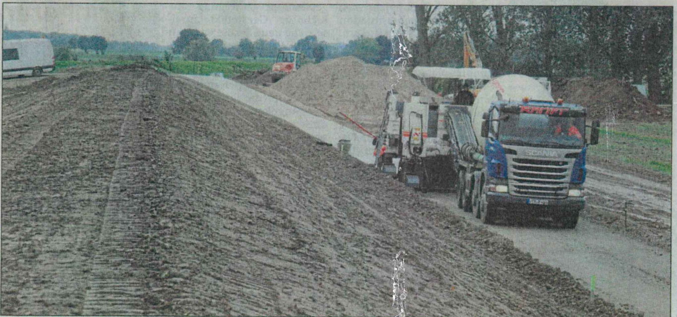
Der Betonfertiger im Einsatz: Mit dem Bau des Verteidigungsweges ist die Deichsicherung im Bereich Oiste weitgehend abgeschlossen.
