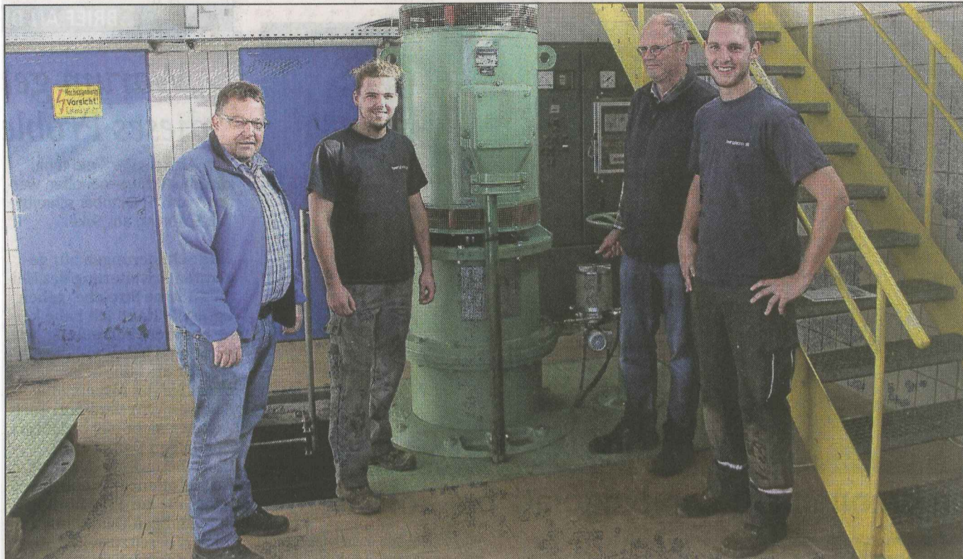
Mittelweserverbandsvorsteher Gerhard Winter (Holtum-Marsch / 2. von rechts) und Geschäftsführer Peter Neumann (links) überzeugten sich vom ordnungsgemäßen Wiedereinbau der Pumpen.
