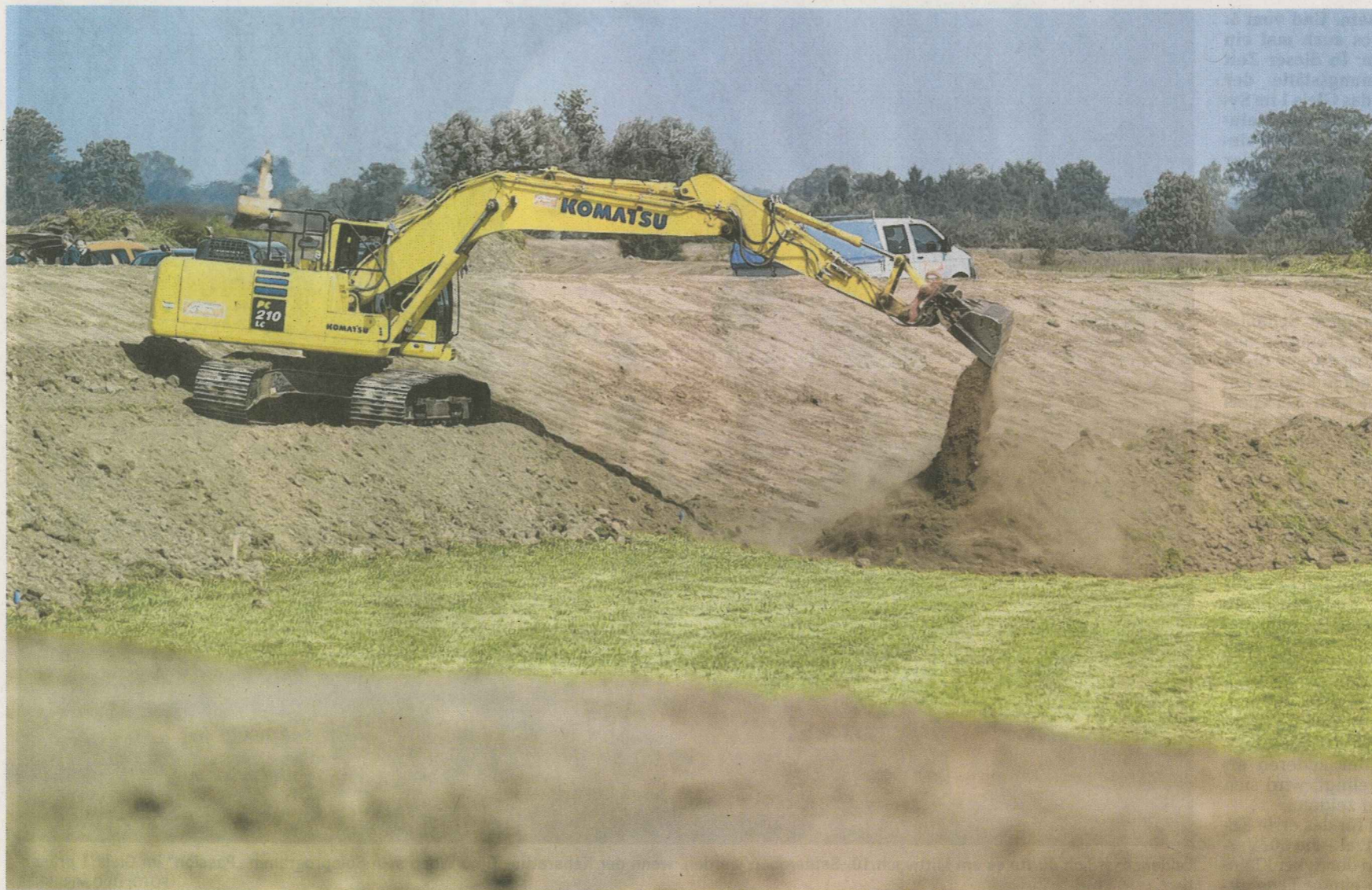
10 000 Kubikmeter Kleiboden sind erforderlich, um den 900 Meter langen Deich von der Flutbrücke in Richtung Amedorf aufzufüllen.
