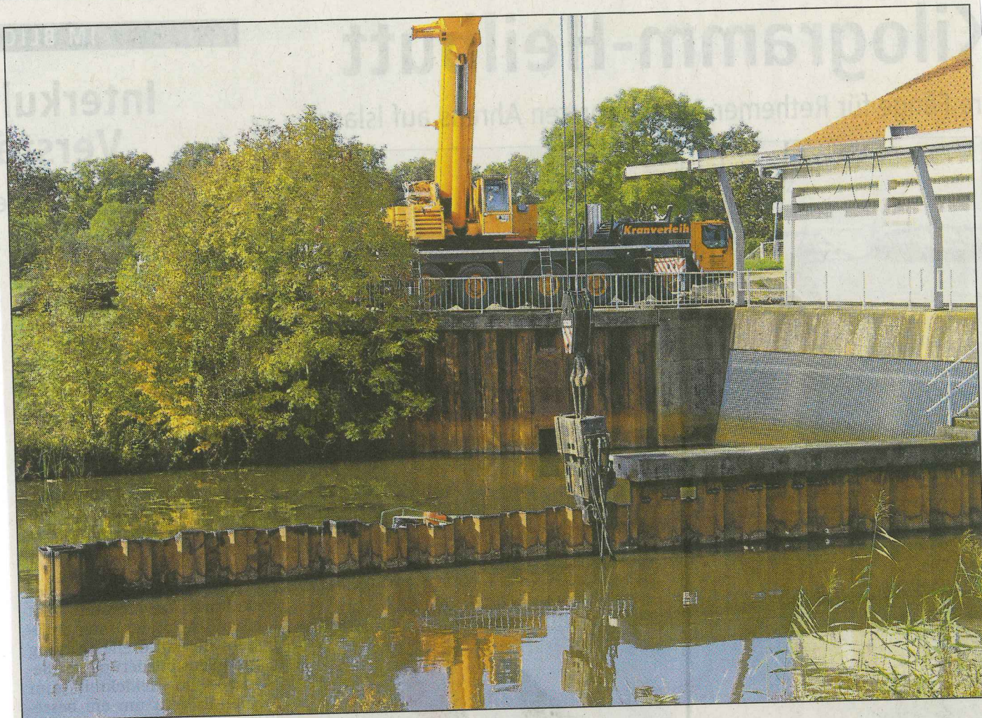
Eine massive Spundwand samt Steg teilt vor dem Schöpfwerk in Thedinghausen-Eißel die Eyter. Das fast 50 Jahre alte Bauwerk ist marode und wird deswegen derzeit mit Hilfe eines großen Krans demontiert. - Foto: sp
