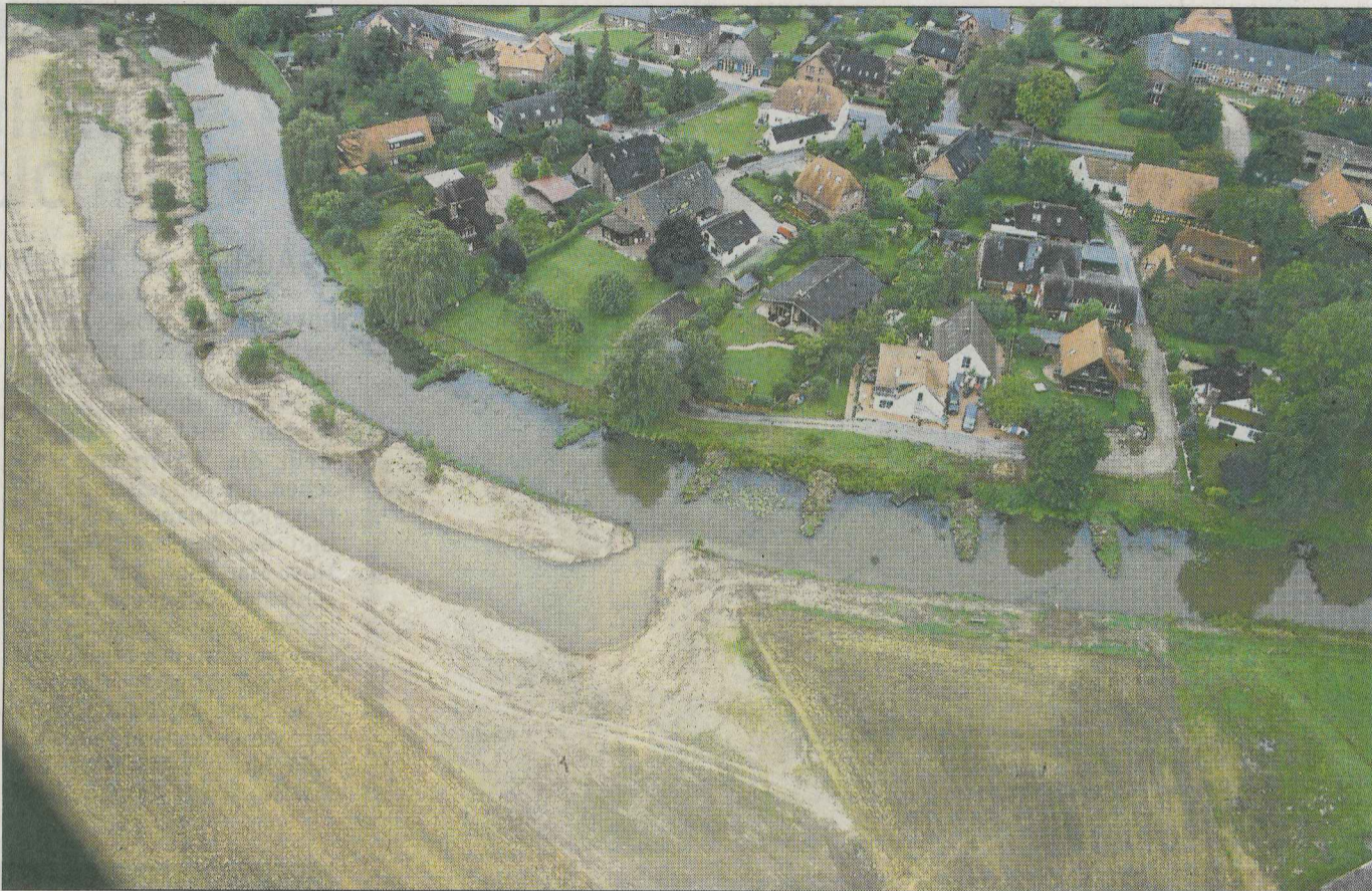
Dem Fluss wird mehr Raum gegeben. Neu angelegte Bühnen sollen die Fließgeschwindigkeit erhöhen. - Fotos: Mittelweserverband
