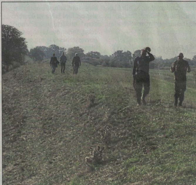
Die Deichschau-Kommissionen waren wieder, wie hier im Bereich Horstedt, entlang der Weser unterwegs. Nennenswerte Schäden an den Hochwasser-Bollwerken waren bei der Inspektion nicht festzustellen.
