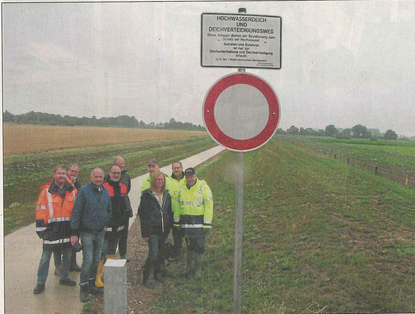
An der Abnahme des Deichneubaus samt Verteidigungsweg und Graben für das Sickerwasser waren Vertreter des Mittelweserverbandes, des Landkreises Verden, des Amtes für regionale Landesentwicklung und des Landesbetriebs Wasserwirtschaft beteiligt. ■ Foto: sp
